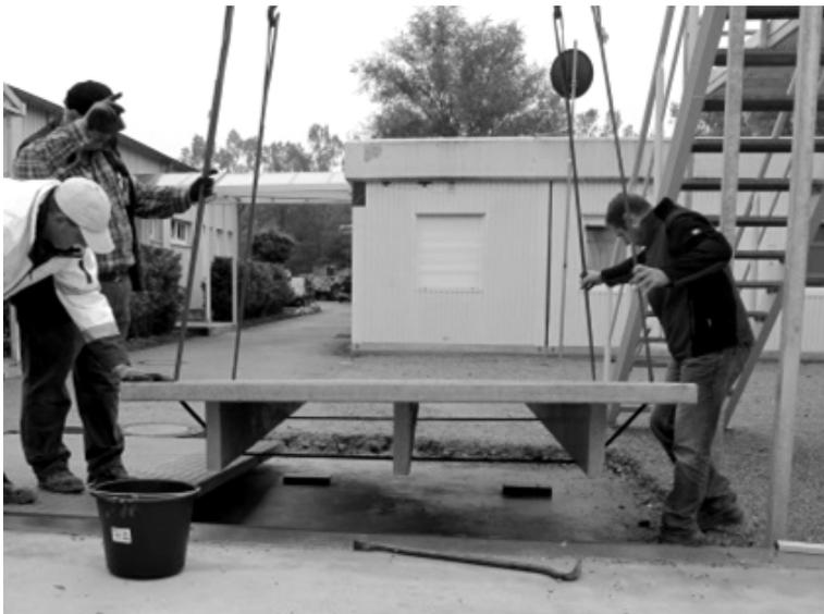
Bild 5: Fertigteilrampe
