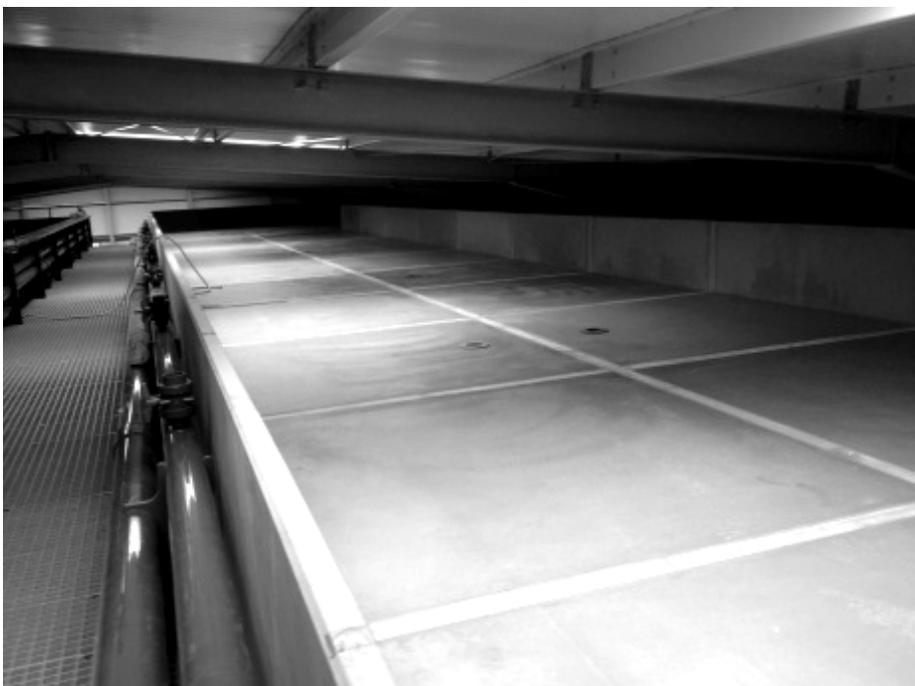
Bild 14: Geklebtes Fischzuchtbecken\*
