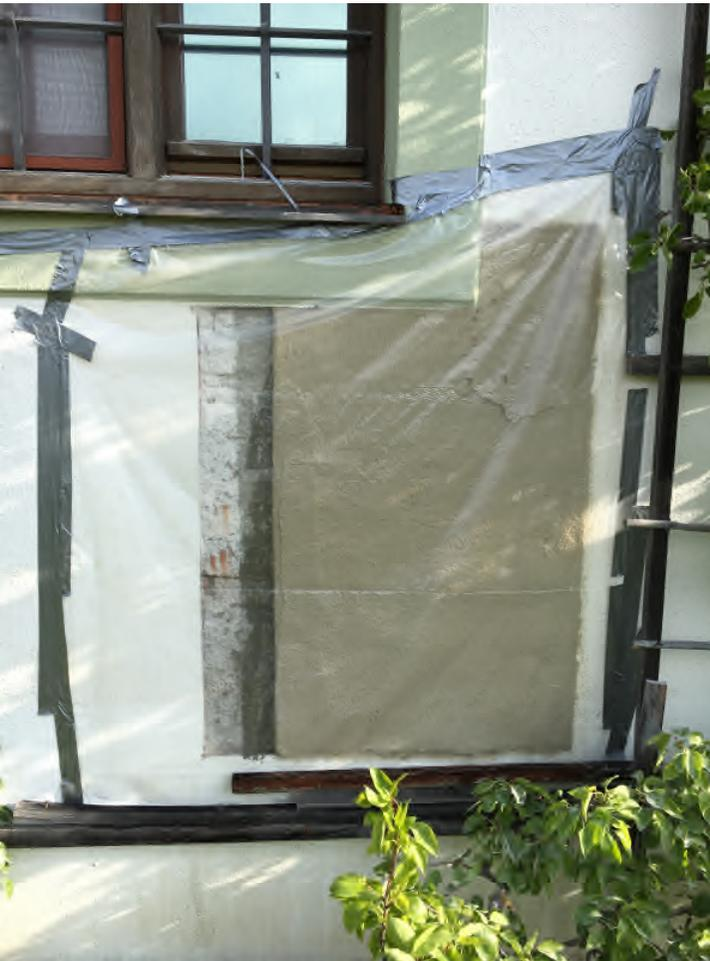
Dämmputzlage vor Wind und zu rascher Trocknung schützen.
