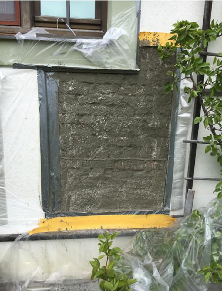
**Vorspritzmörtel zur Verbesserung der Haftung und zur Egalisierung des Saugverhaltens aufgebracht.**
