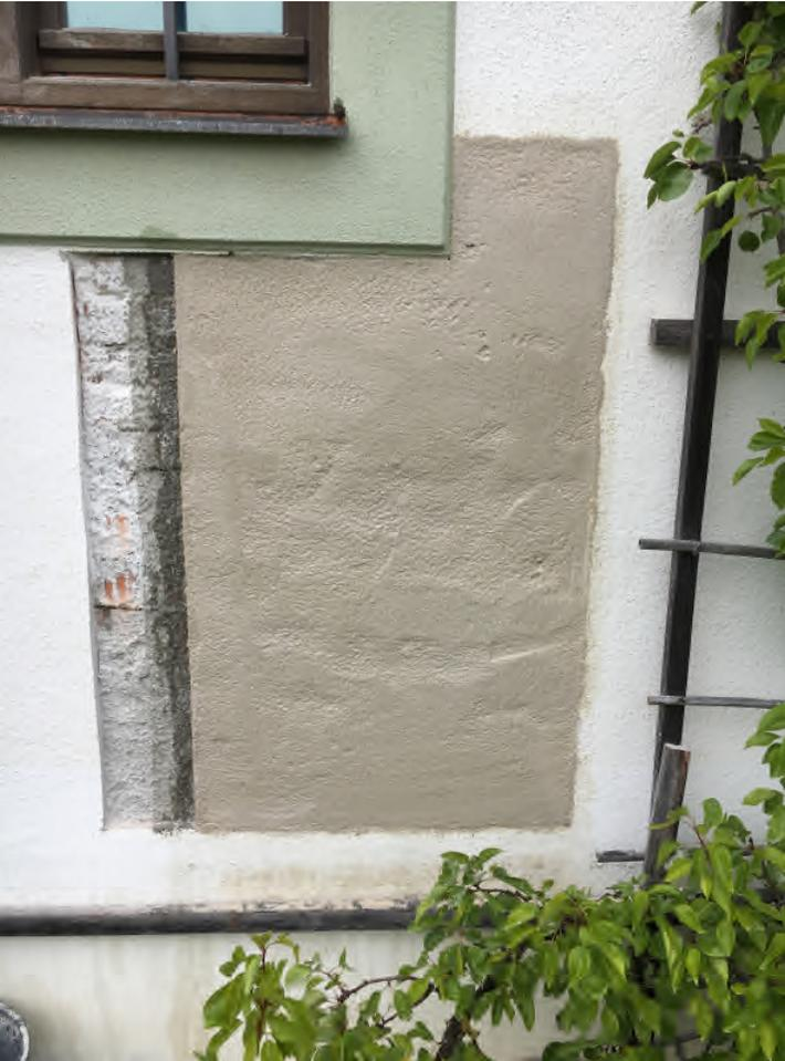
**Fläche abrabottiert (geglättet und Oberfläche aufgeraut). Mineralischen Untergrundstabilisator aufgebracht.**
