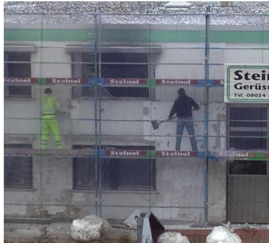
*Entfernen der EPS-Platten mit einem Eisschaber*
