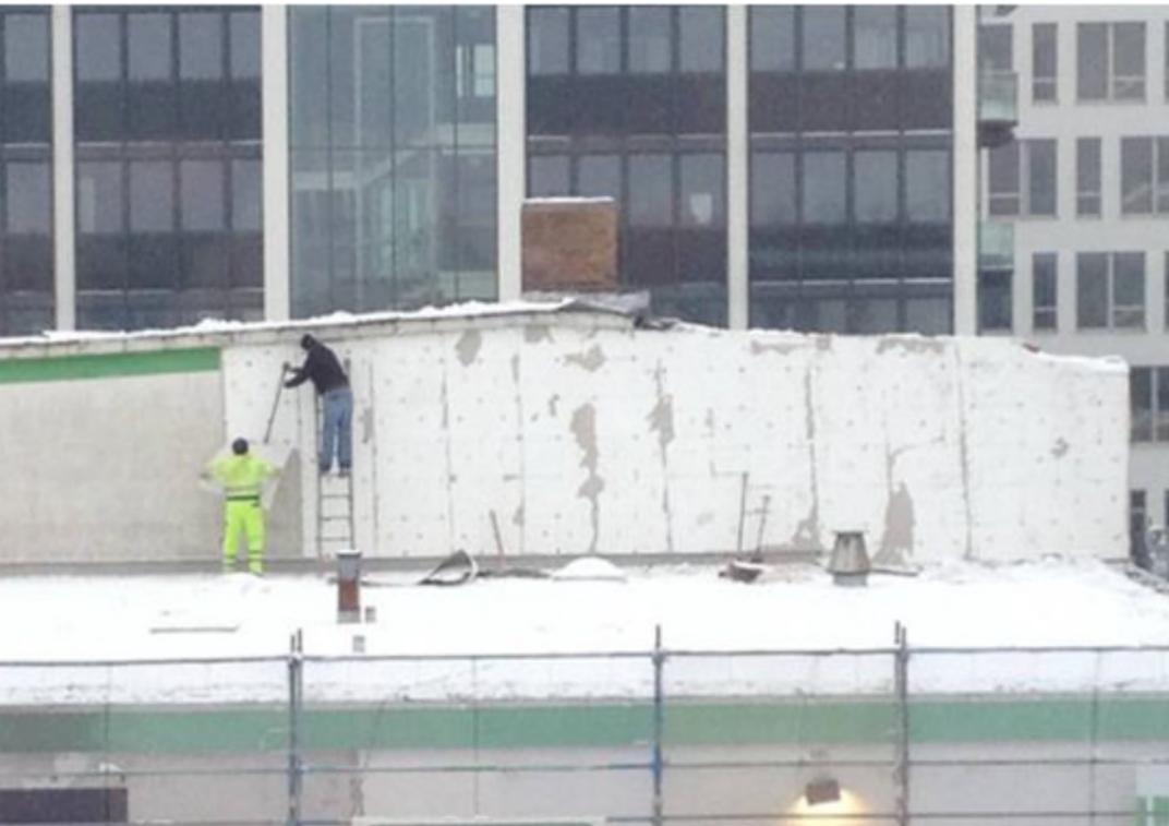
*Abtragen der Putzschicht mit einem Eisschaber, Gräfelfing 2011*
