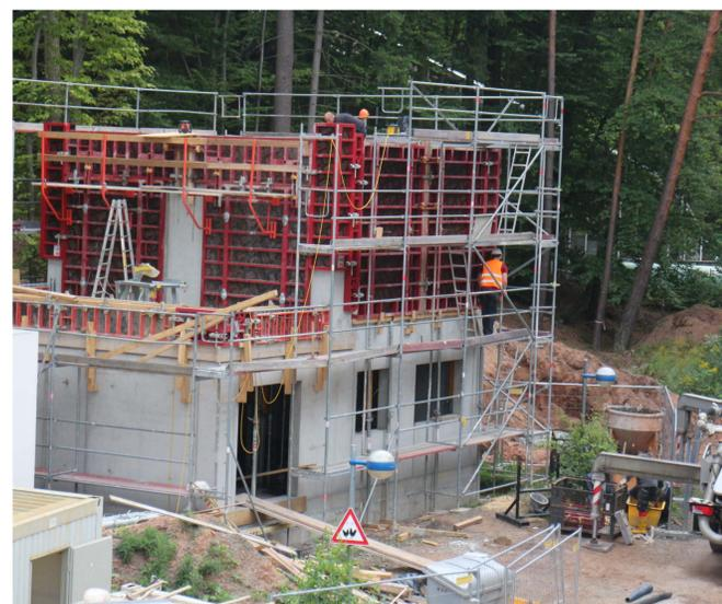
**Bild 3:** Deutschlandweit erstes Gebäude vollständig aus **R-BETON** - Rohbau des Großdemonstrators Small House III auf dem Campus der Technischen Universität Kaiserslautern
