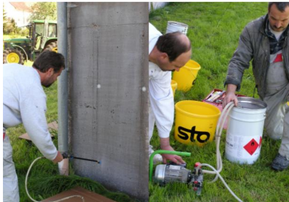
Demonstrator: Applikation einer Tiefenhydrophobierung,
